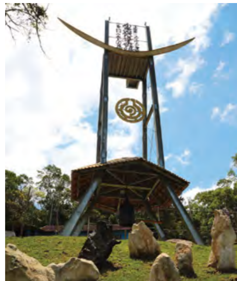
A torre que sustenta o sino é o ponto de partida da construção de um templo budista.
